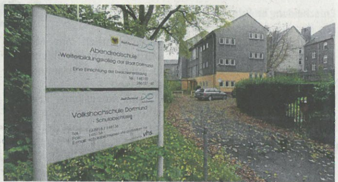
150 Flüchtlinge können vorübergehend in die ehemalige Abendrealschule an der Adlerstraße einziehen. FOTO: ARCHIV
